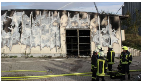
Der Stall brannte komplett nieder.
